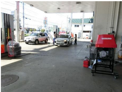
長期停電で殺到する車に、自家発電機を稼働させて燃料の限定給油を続けた札幌市内の中核SS
