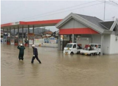
7月6日、西日本豪雨災害で冠水した岡山市内のSS
