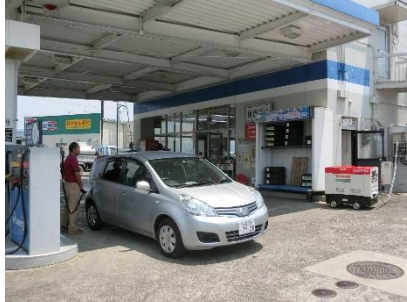
西日本豪雨災害で停電した愛媛県大洲市の住民拠点SSでは、自家発電機を稼働させて燃料供給を続けた
